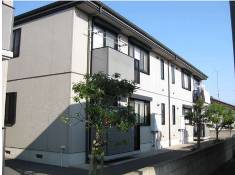
積水ハウス施工
